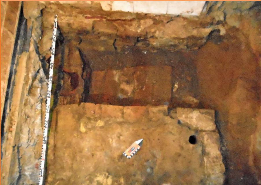
Foto 3. Vista un cop extret la pavimentació actual. De dalt a baix: fonamentació UE 10; restes de la claveguera UE 5, afectada pel negatiu UE 12; i pou UE 3, amb la seva coberta UE 4.
