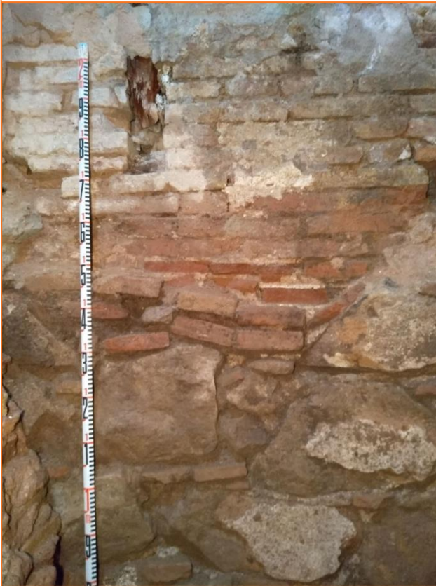
Foto 9. Vista del límit oest, amb el parament de maons UE 9 assentat sobre el rebaix UE 14, que afecta el mur
