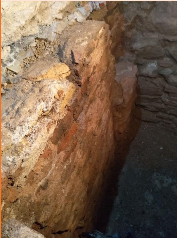
Foto 7. Detall del límit sud del fossat. D'esquerra a dreta: fonamentació del mur UE 18, i la petita reparació amb morter blanc UE 20; basament del mur UE 15; i al fons la fonamentació del mur UE 10.
