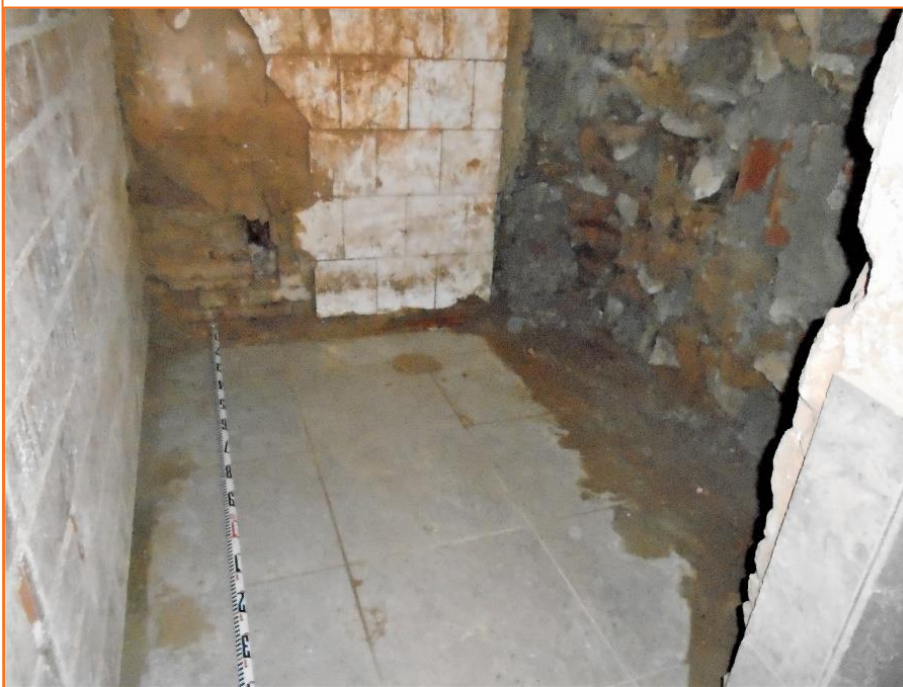
Foto 2. Vista de l'espai a l'inici de la intervenció. D'esquerra a dreta: envà aixecat per l'obra UE 13; paviment UE 1; i el mur UE 11 seccionat verticalment pel negatiu UE 21, amb el revestiment de ciment ja extret.
